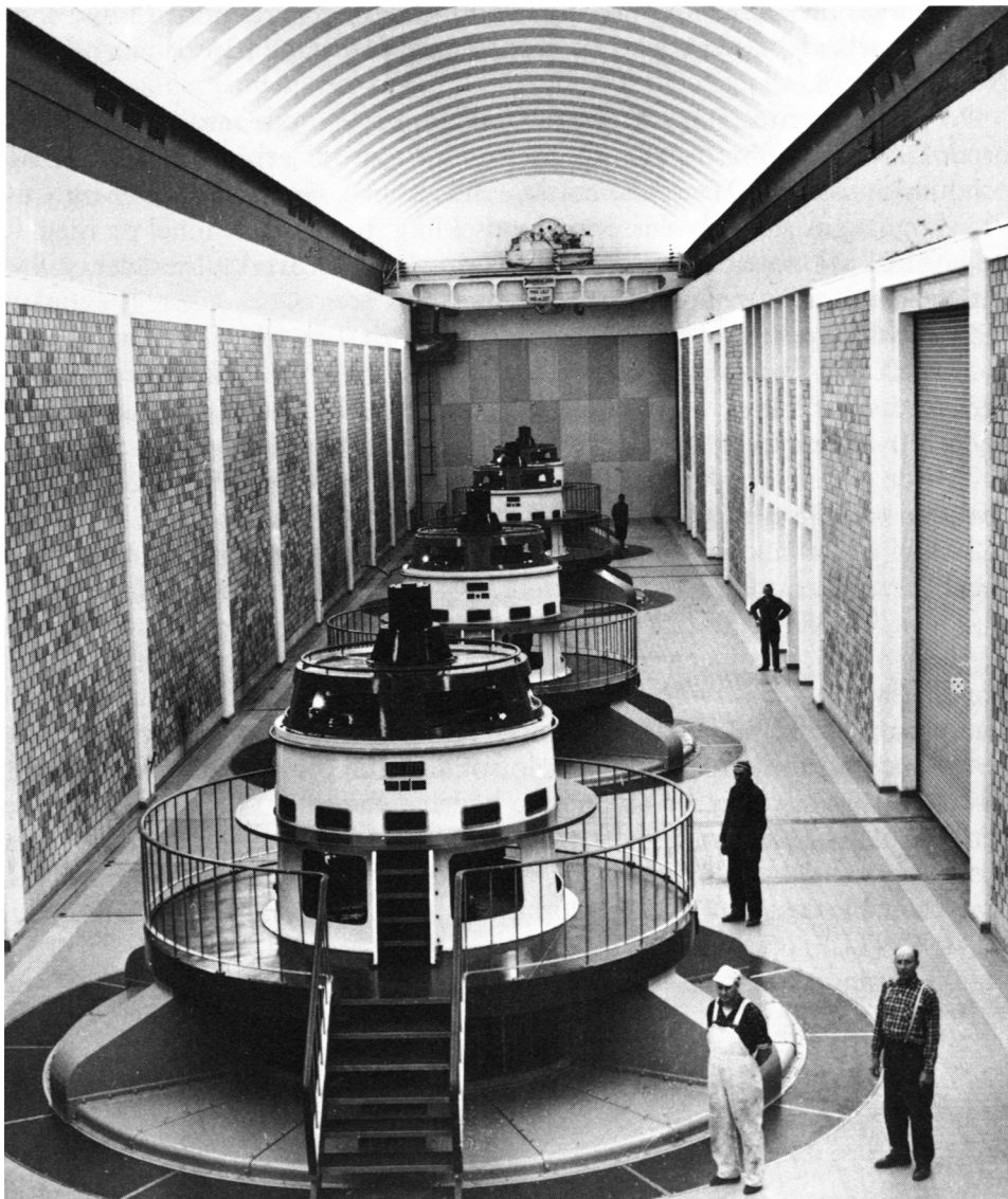
Etter krigen ble kraftstasjonene som regel lagt i fjell. Interiør fra Tokke I (NVEs informasjonsskontor).
