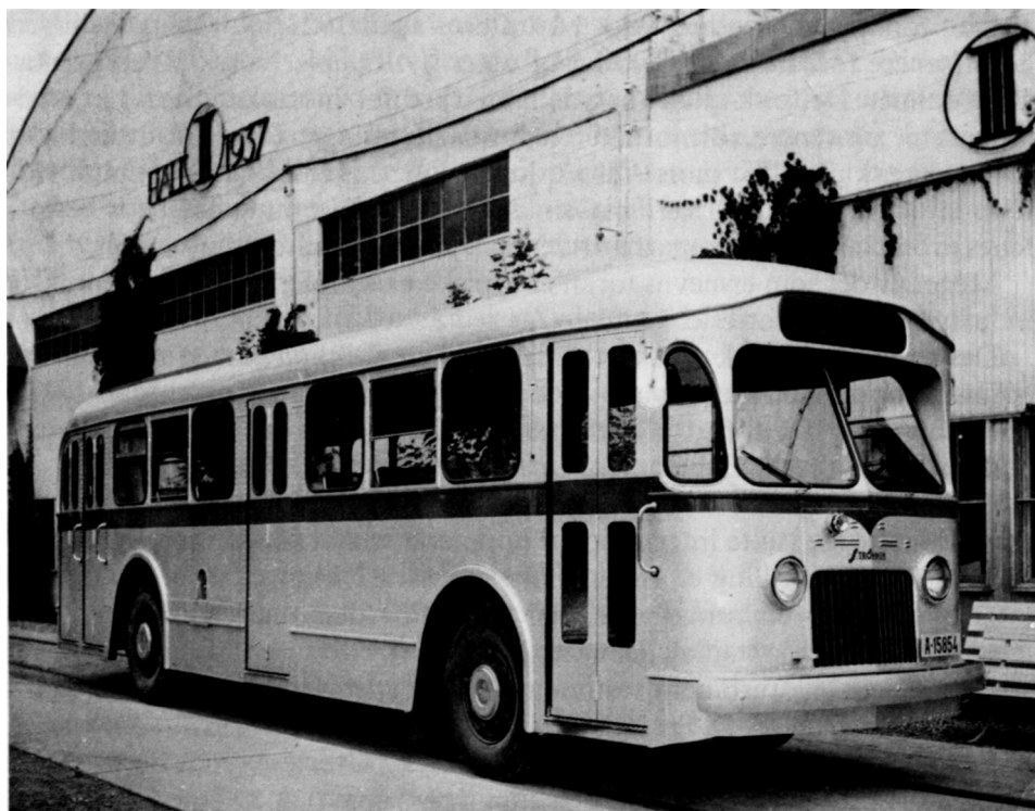
Strømmens Værksted's «chassisløse» buss av duraluminium konstruert i 1929. (Senere utgave).
