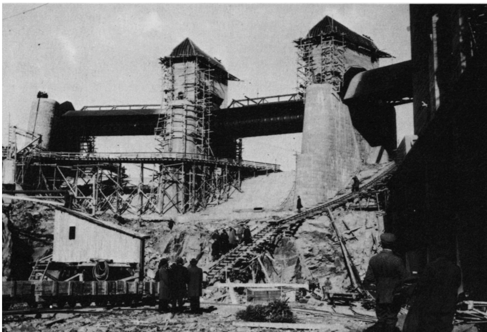
Dammen ved Solbergfoss kraftanlegg 1922. (NTMs arkiv).
