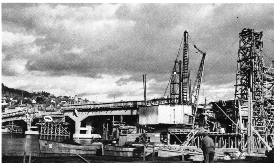
Bybroen i Drammen ble i 1934 sendt ut til anbud som platebro av stål. Ingeniør Fredrik Selmer slo et slag for armert betong, ved egen konstruksjon, og fikk entreprisen. Han ble i 1932 tildelt Eydes pris for fremragende jernbetongarbeider. Eydes pris ble samtidig tildelt ingeniør August Gundersen i Høyer-Ellefsen AS.
